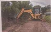
"Arreglo de cañales y ampliación del sistema de drenaje en el barrio La Javilla."
