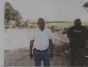
Arreglo y hacho de materiales en el camino de Jalongo cerca del Liceo Buen Samaritano
